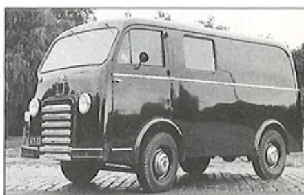
Ein 46-PS-Hercules-Motor trieb den Transporter A 10 an.
