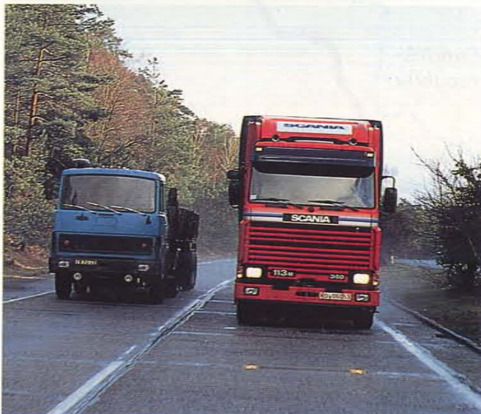
Autobahnen im Urzustand mit Betonplatten und Querrippen
