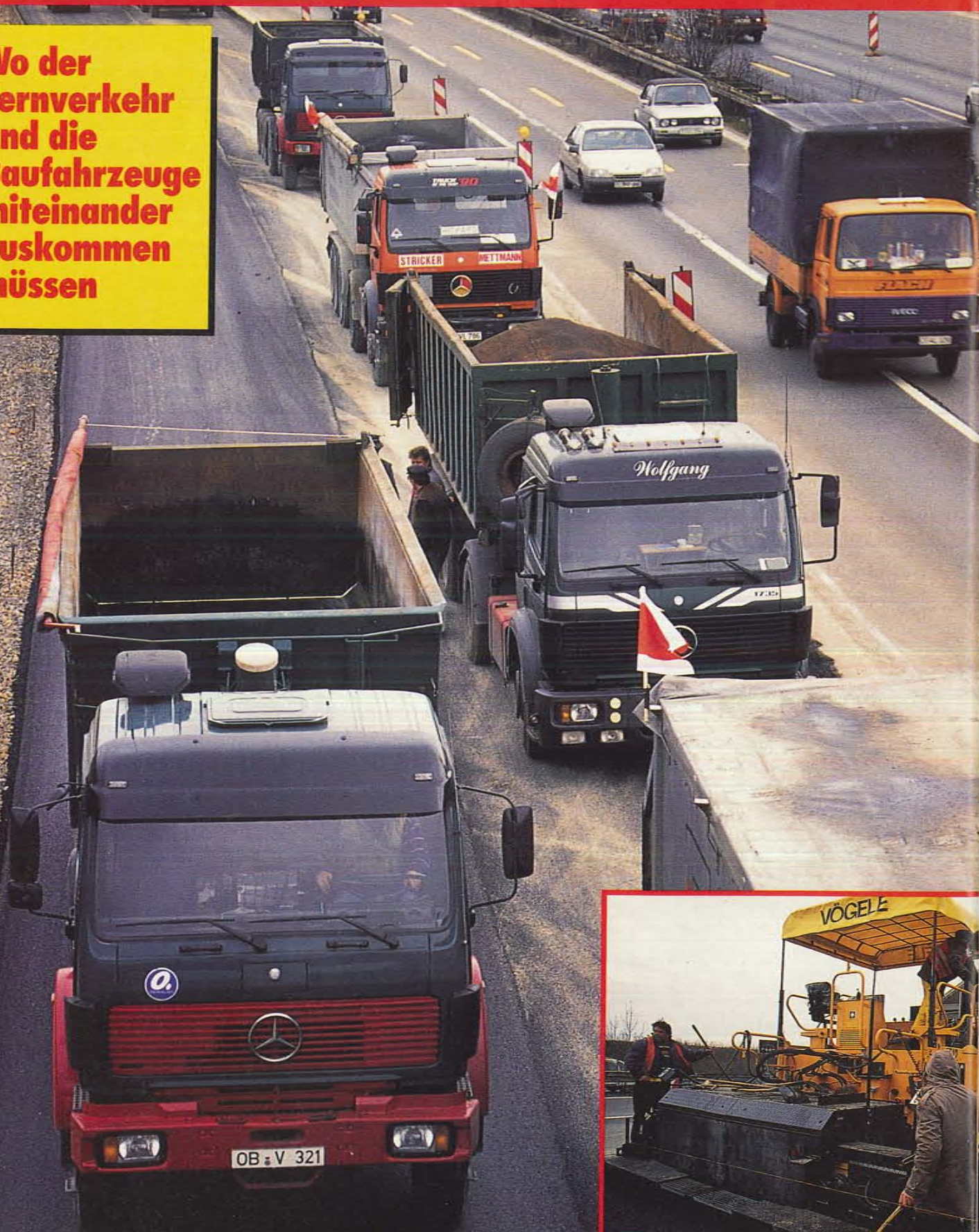
Binderschicht: Straßenfertiger legt 8,5 Zentimeter Bitumen und Split
