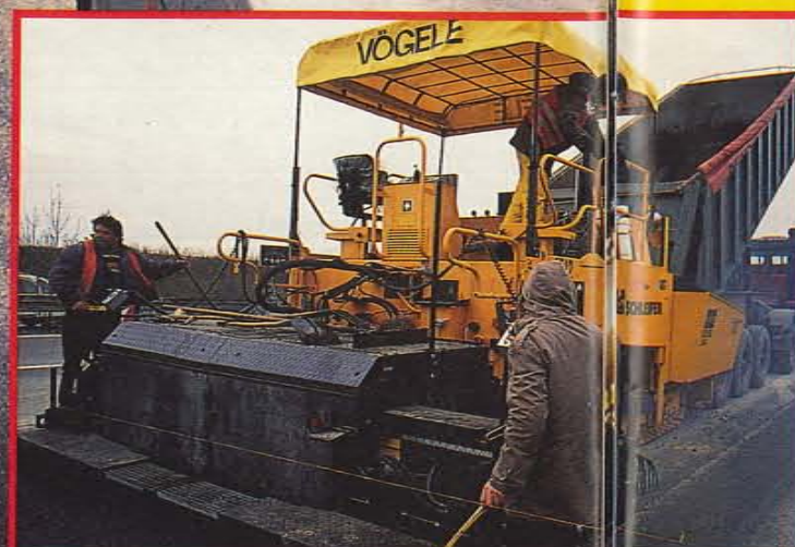
Binderschicht: Straßenfertiger legt 8,5 Zentimeter Bitumen und Split
